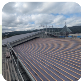
かわら ぶ じゅんび 瓦を葺く準備
