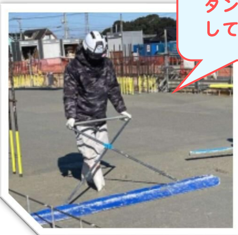
タンプーという道具を使って 表面を叩いて締め固めます
