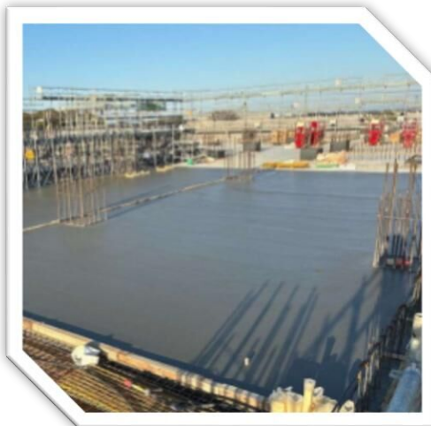
コンクリート打設完了！
