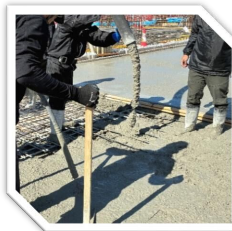
コンクリートを流し込みます
