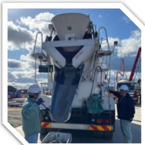
大きなミキサー車で コンクリートを運ぶよ！
