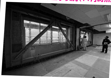
北側会議室の工事状況(11月時点)
