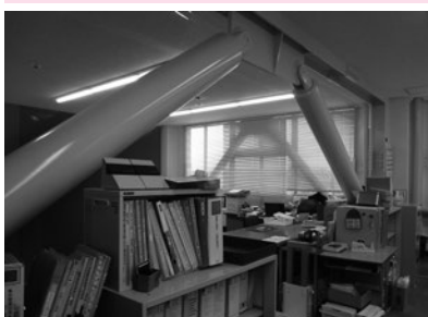
2階工事後の現在
