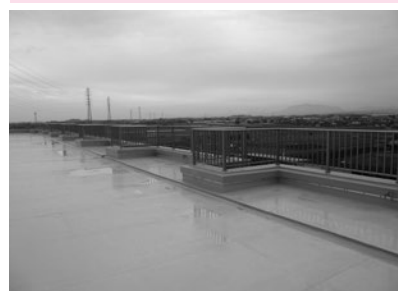
屋上防水工事・手すりの軽量化
