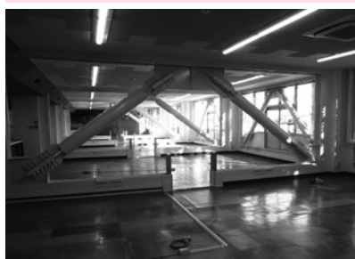
1階工事完了後
