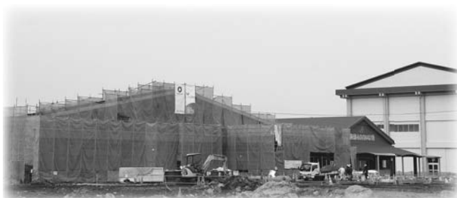
工事がすすむ築上北高跡地
