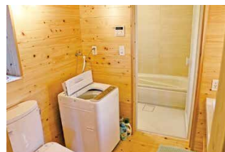
▲ 洋風に改修済みの浴室・トイレ
