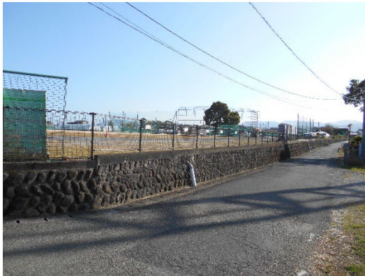
西側敷地境界擁壁
