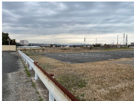
北側敷地（南側より）
