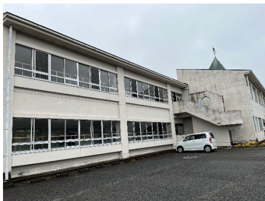
校舎外観（北側）
