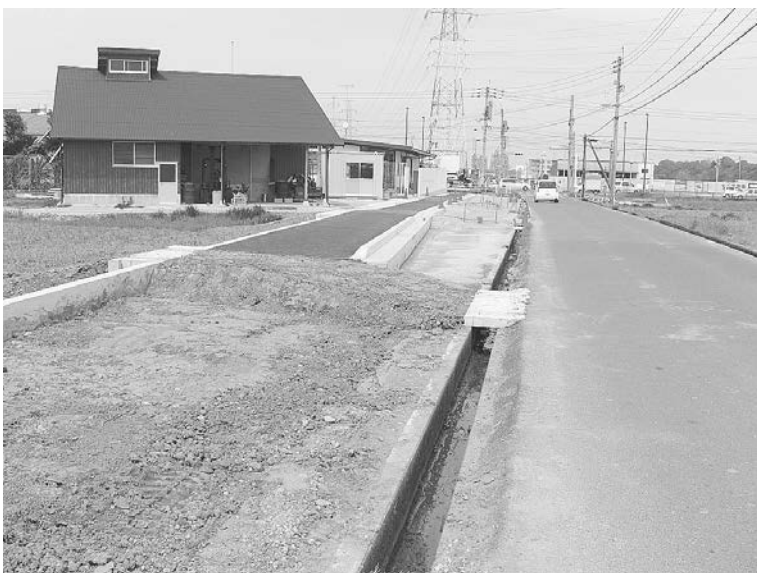
県道中畑～八屋線の道路拡幅工事の様子
