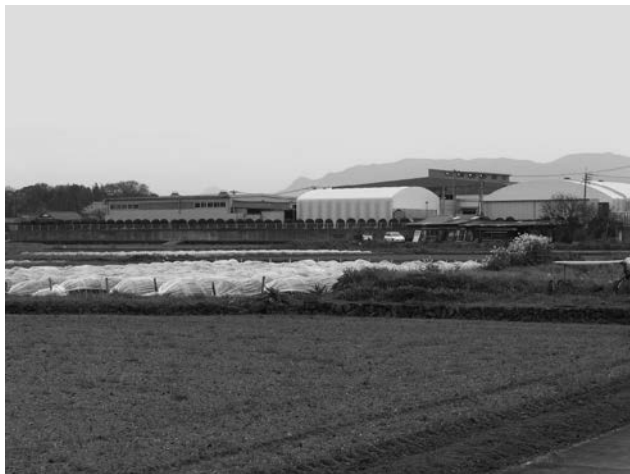
小石原工業団地付近
