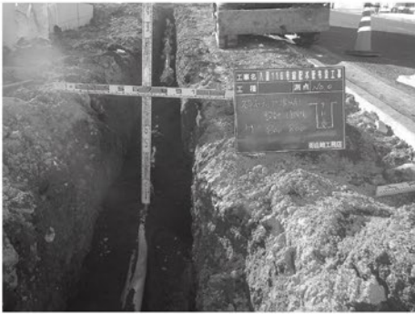
上水道の工事現場の様子
