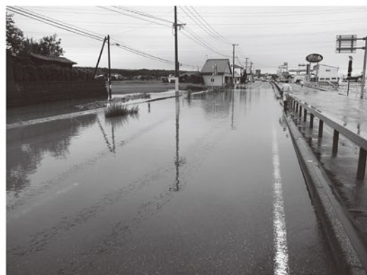
大雨により鈴子川が氾濫し、水没した国道10号線の様子(平成24年)
