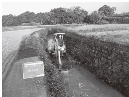
鈴子川の浚渫作業の様子
