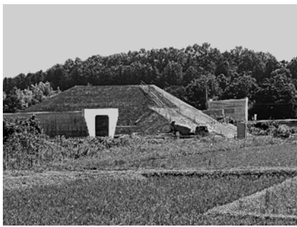
東九州自動車道工事現場
