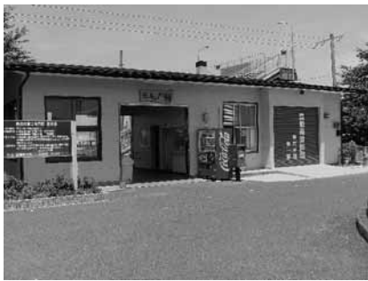
改修後の三毛門駅舎
