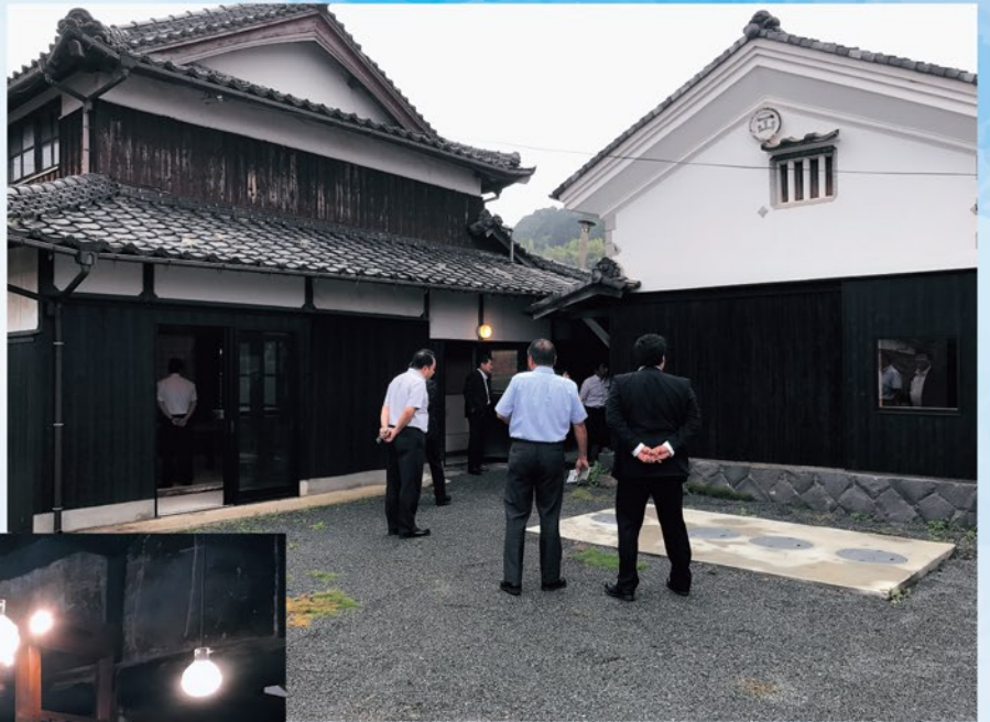
改修された古民家外観
