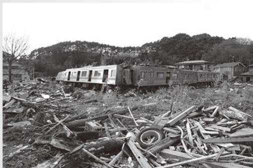
【被災後の状況】
