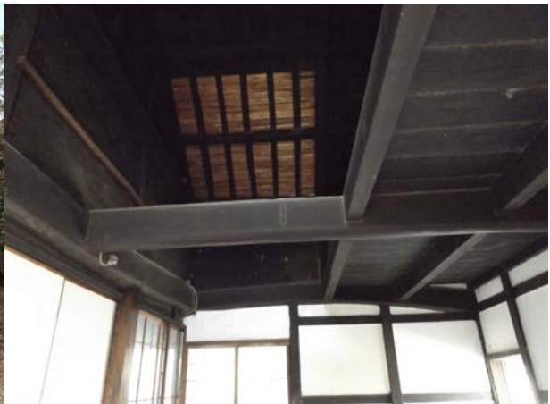
土間の天井の梁
